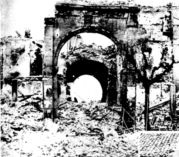
Ruinas del Ayuntamiento de Toledo, uno de los edificios más bellos de la ciudad, destruido por la metralla de las tropas gubernamentales.
